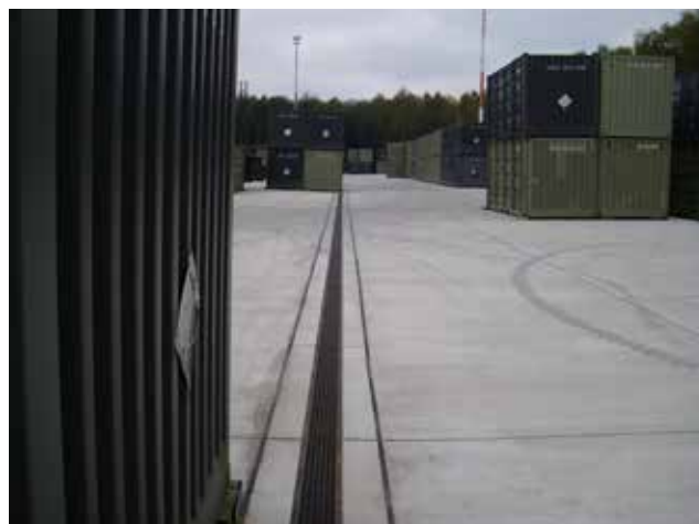
Konteinerių terminalas, Ramštainas, Vokietija Įrengti FASERFIX®KS latakai
