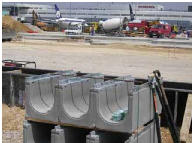
Oro uostas, Varšuva, Lenkija Įrengti FASERFIX®SUPER latakai
