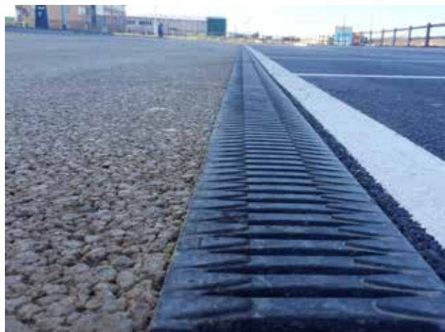
Aikštelė, Jungtinė Karalystė Įrengti RECYFIX®MONOTEC latakai
