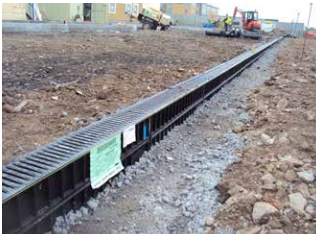
Aikštelė, Jungtinė Karalystė Įrengti RECYFIX®MONOTEC latakai
