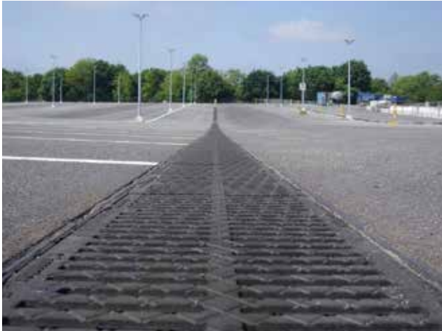
Aikštelė, Vofsburgas, Vokietija Įrengti RECYFIX®PLUS X latakai
