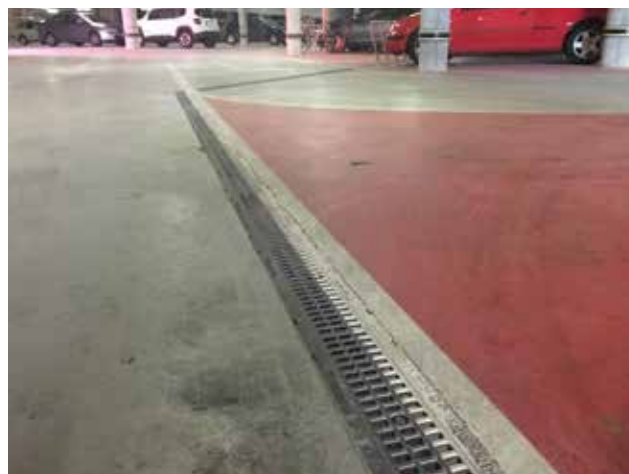
Požeminė aikštelė, Gdynė, Lenkija Įrengti RECYFIX®PRO latakai
